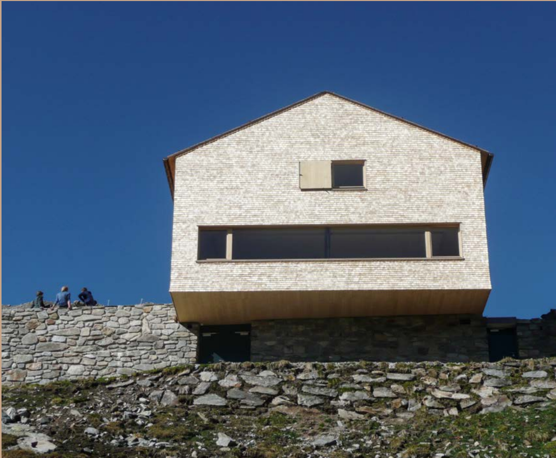
Olpererhütte // Auf 2400 Metern wurden die in der Zimmerei vorgefertigten Elemente mit dem Helikopter angeliefert. Hermann Kaufmann: „Einziger Luxus ist das riesige Panorama-fenster ins Tal. Doch dafür kommt man ja rauf.“
