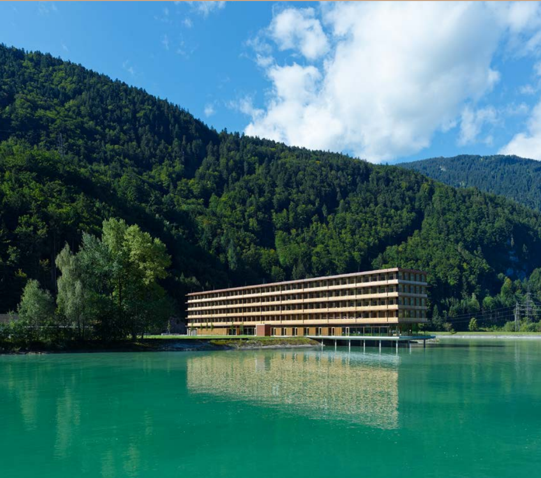
Illwerke Zentrum Montafon, Velden // Superlative im Supertempo: Zum Zeitpunkt der Fertigstellung 2013 war das 120 Meter lange Zentrum das größte Bürogebäude aus Holz in Mitteleuropa, das Fügen der Holzkonstruktion brauchte gerade einmal sechs Wochen. Um es auf der Bafläche unterzubringen, ließen die Architekten den Riegel über den See kragen. Mittlerweile wurden auch andere Holzgebäude in ähnlichen Dimensionen realisiert.
