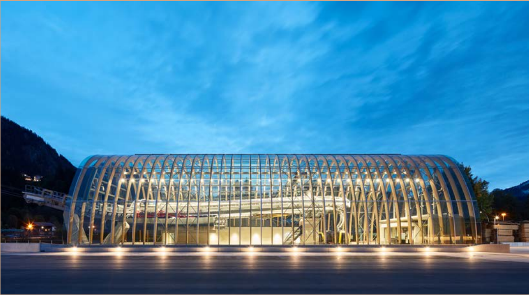
Nebelhornbahn Talstation, Oberstdorf – Kleinwalsertal // Mitten im Ort und eingebettet in die Allgäuer Alpen, verteilen sich die Funktionsbereiche der Luftseilbahn auf drei Gebäude. Die Station selbst besteht aus Holzparabeln und gebogenem Glas.
